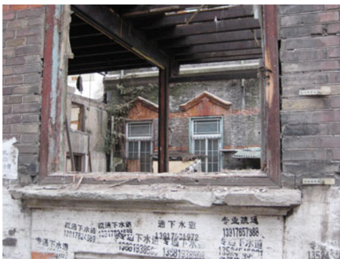
Shanghai, Häuser im Abriss, 2008 Foto: ML
