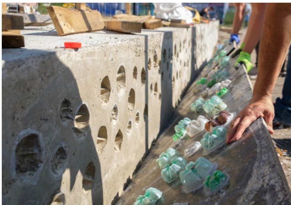
Платната на кофража декорирахме с дъна от пластмасови бутилки, капачки и играчки. Сортирахме, рязахме, подреждахме, прикрепяхме, уплътнявахме. Така, след изливането на бетона, в пейката останаха негативни отпечатъци от предметите.
