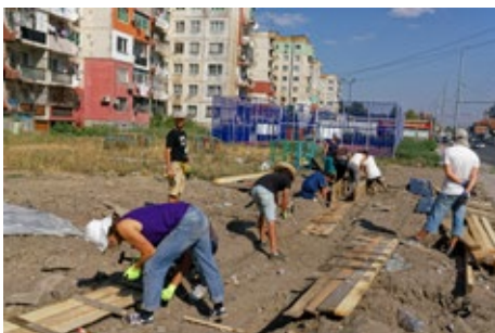
„Дългата пейка с навес“ направихме за Столипиново, за една полуизоставена поляна на улица „Крайна“. За нея работихме с Берул, Здравко и Карло: правихме кофраж и армировка, ляхме бетон и шлайфахме, монтирахме и украсявахме.
