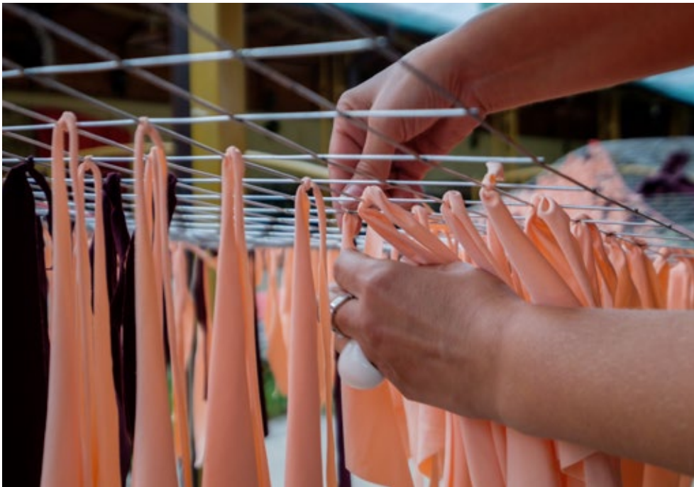
За да оформим артистичното покритие на навеса, селектирахме подходящите цветни ленти, сортирахме, нарязвахме и вързахме над 9000 възела на почти всяка връзка на поцинкованата мрежа.
