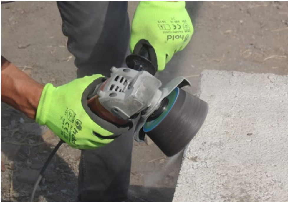
При изливането на бетона, заравняването, вибрирането и шлайфането много се изцапахме, но постигнахме гладка и истинна бетонна повърхност.
