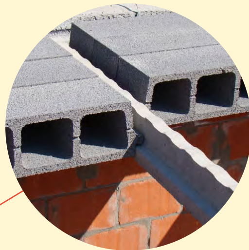
COUVERTURE béton hourdis
