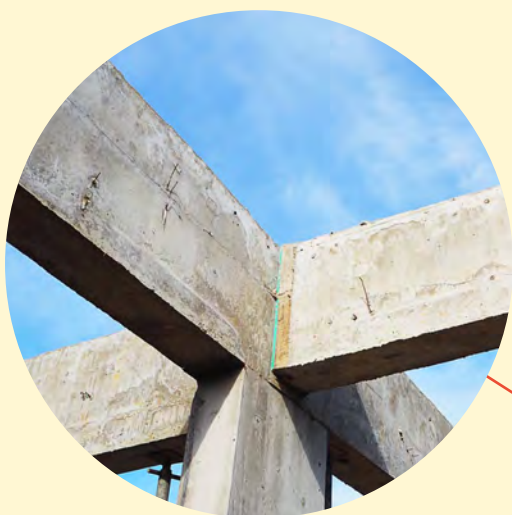
STRUCTURE béton ciment coulé
