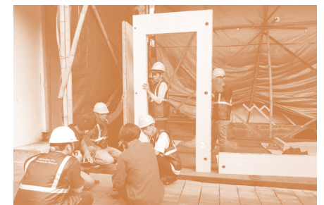
(13) Proses perakitan kayu prefabrikasi
