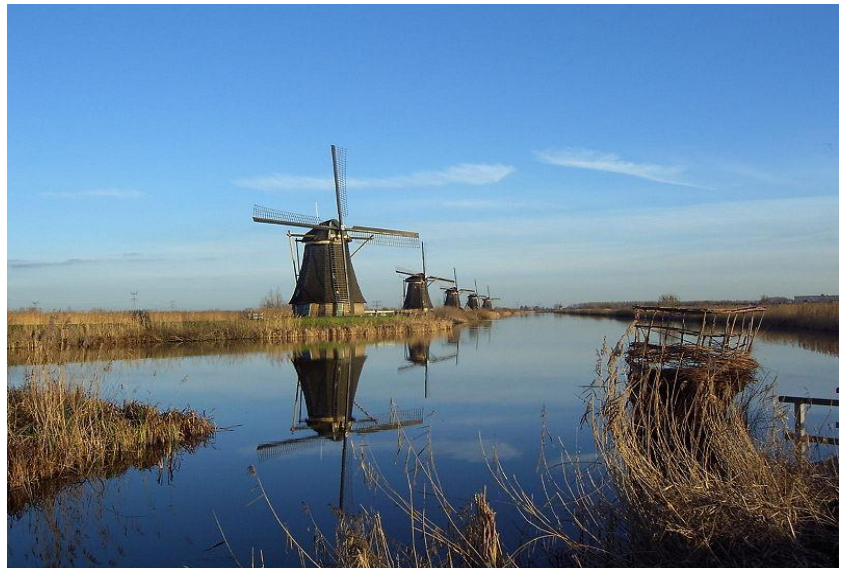
Abb.40 (Pumpen-) Mühlen auf dem Deich des Overwaard-Polders
